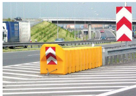
d) tlumič nárazu – tlumení kinetické energie v případě nárazu, snížení následků havárie
