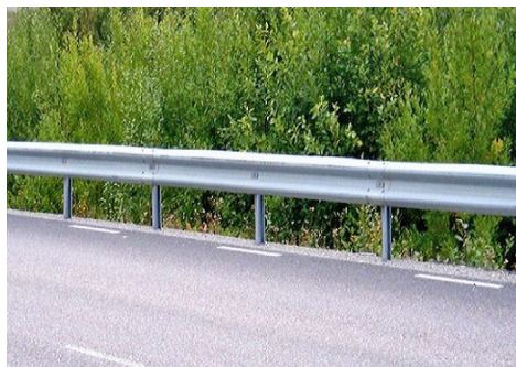
b) svodidlo – zabránění vyjetí mimo vozovku, srážce s pevnou překážkou
