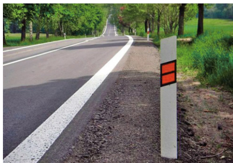
c) směrový sloupek – vyznačení okraje silnic, přispívá k orientaci řidičů zejména za snížené viditelnosti
