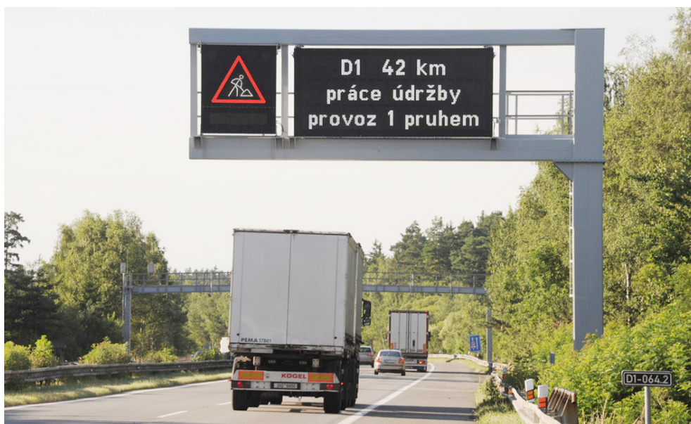
Informační tabule na dálnici Zdroj: www.dopravniinfo.cz
