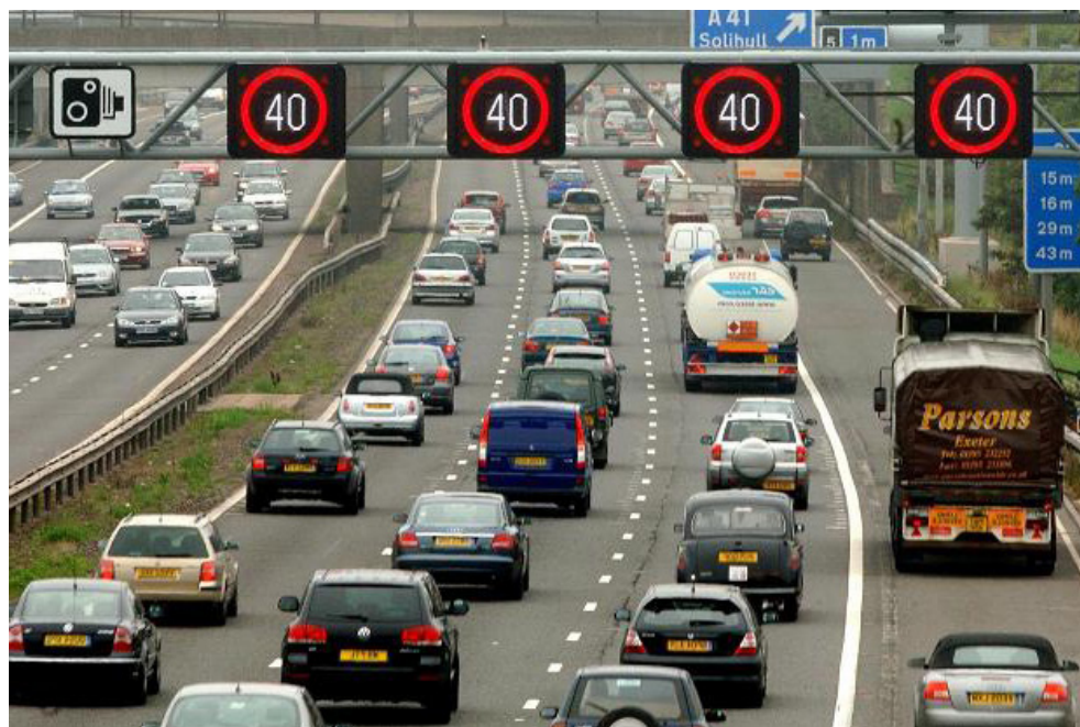
Obrázek 16: Typická aplikace liniového řízení provozu s možností vyhrazení nebo uzavírání jízdních pruhů
