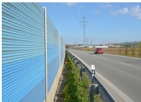
b) protihluková stěna vyplněná skelnou vatou, na povrchu je plast
