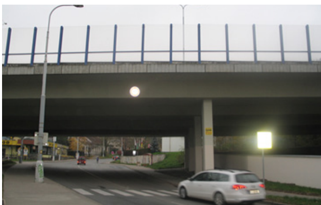
Průhledná stěna umístěná na nadjezdu
