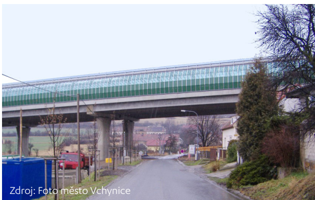
Protihlukový tunel nadúrovňový u města Vchynice
