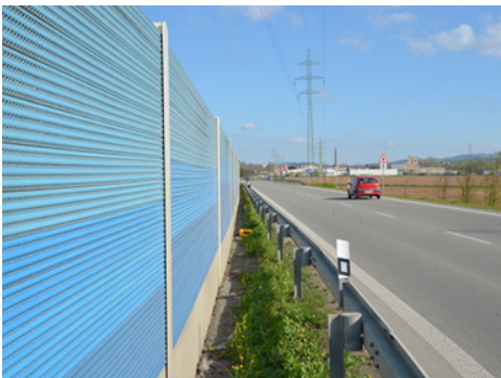
a) Protihluková stěna s výplní skelné vaty, na povrchu krytá plastem
