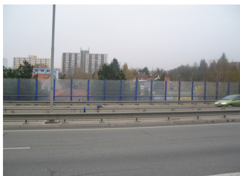
c) plastová protihluková stěna
