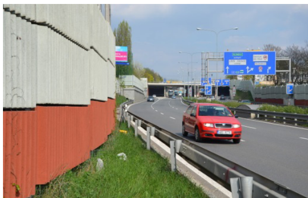
Neprůhledná betonová stěna
